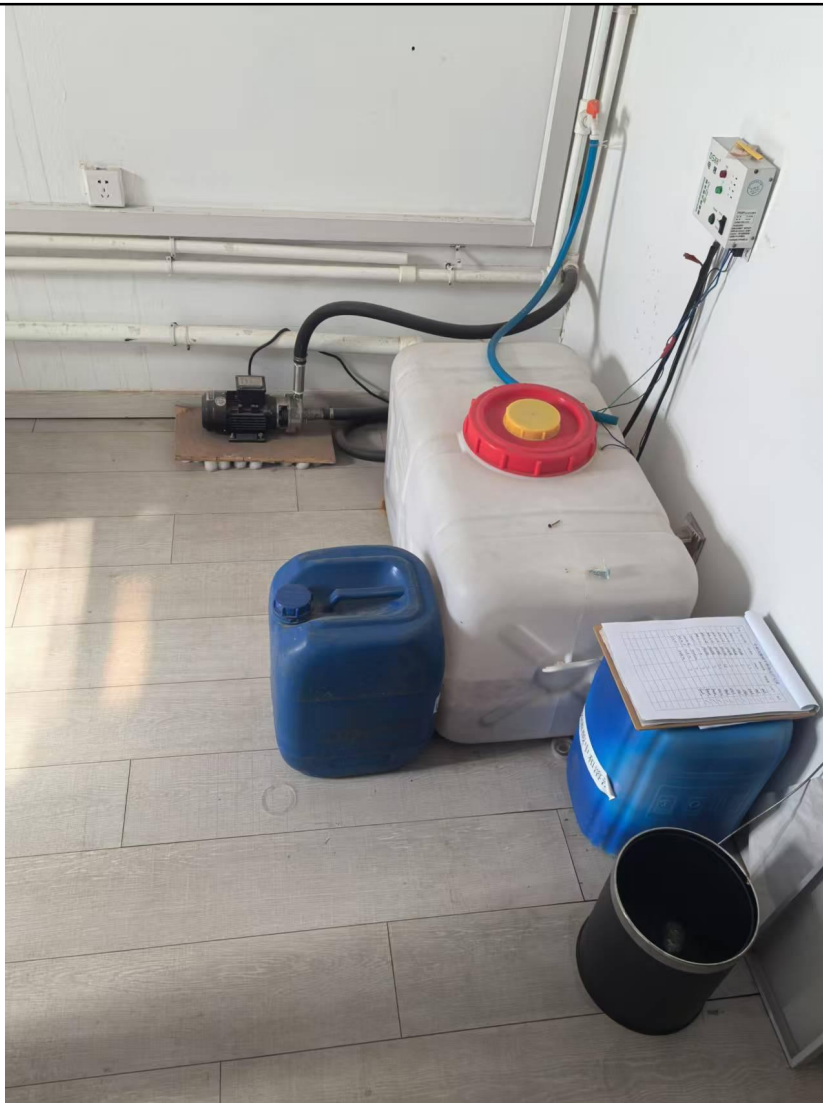
图 2-7 现有废水中和处理装置（拟拆除）
