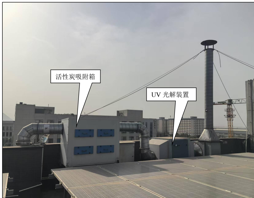
图 2-8 现有废气处理装置（拟拆除）
